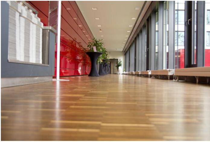
Der letzte Arbeitsgang, die UV-Aushärtung der Decklackschicht, begann am Sonntag früh um 8 Uhr und endete um 10.30 Uhr. Im Anschluss daran räumten die Mitarbeiter der Firma Sauer die Kantine wieder ein. Die Abnahme der Fläche erfolgte um 14 Uhr – 47 Stunden nach Arbeitsbeginn. Kurz darauf rollte auch schon der erste Hubwagen mit einem etwa 500 kg schweren Getränkeautomat über das
