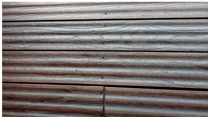
Восстановленная терраса из термоясеня после обработки лаком DeckFinish цвет темно-коричневый.
